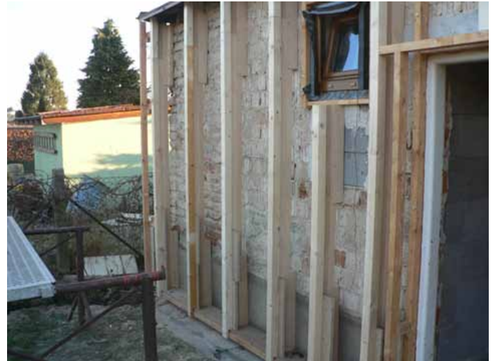
Obr. 2 - Instalace expandérů na stávající fasádu včetně vyrovnání.
