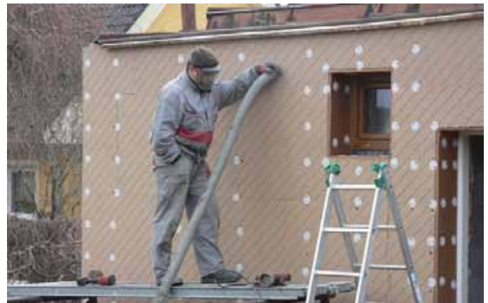
Obr. 4 - Aplikace foukané celulózové izolace do izolačního prostoru kapsy.
