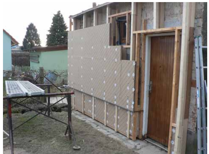
Obr. 3 - Montáž dřevovláknitých desek jako podklad pro omítku.
